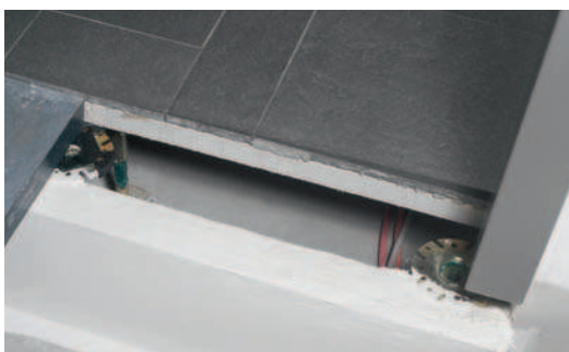
Verbund-Doppelboden in Nasszelle belegt mit keramischem Belag
