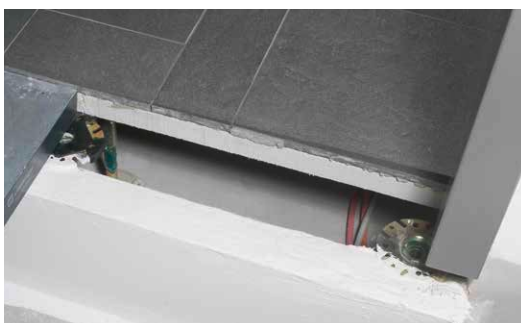
Verbund-Doppelboden in Nasszelle belegt mit keramischem Belag
